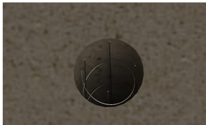
Figura 4 - Armação deve ficar nivelada com o solo
